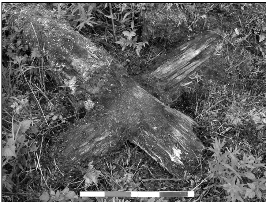
Рис. 3. Угол нижнего венца сруба Троицкого храма 1796 г.
